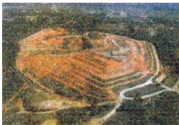
Foto 16: Aterro Sanitário da Cachimba do Município de Curitiba-PR (1997)
