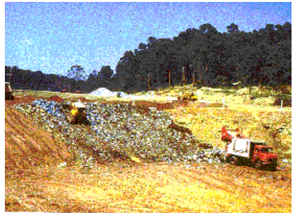
Foto 29: Aterro Sanitário de Município de Médio Porte. Situação encontrada na minoria dos municípios brasileiros.
