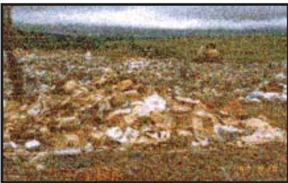
Foto 5: Lixão do Município de Passo Fundo-RS (1995) Resíduos apenas espalhados com o trator de esteiras sem cobertura e drenagem de chorume e gases.
